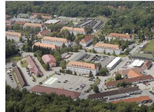
Ressourceneffiziente Stadtquartiere in Darmstadt
